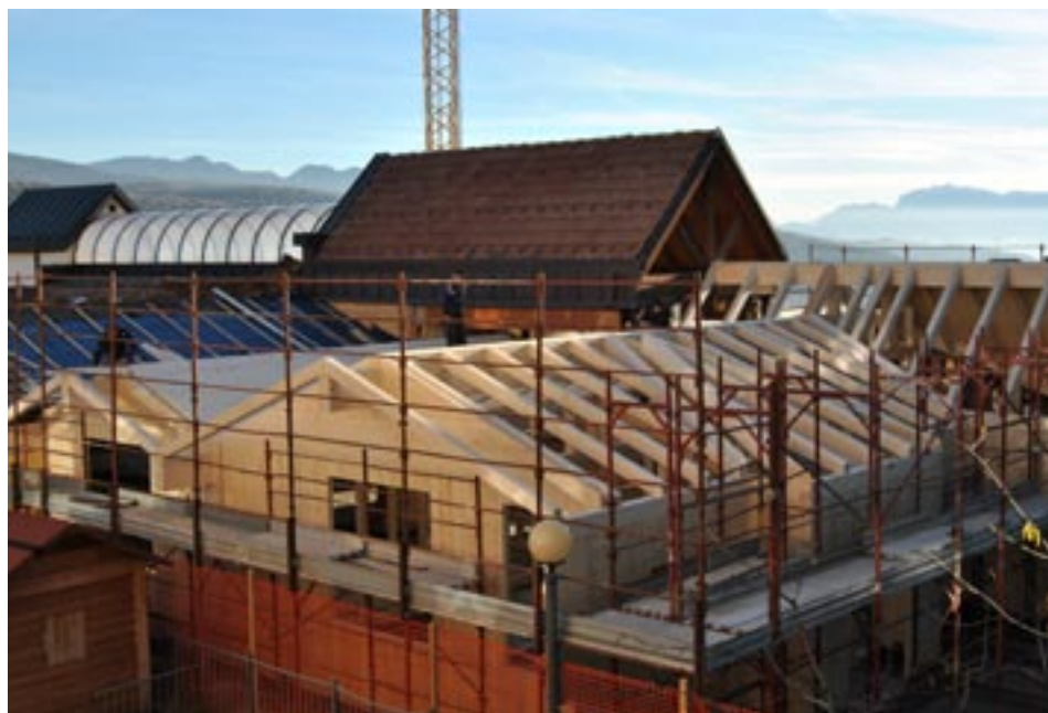
Il cantiere della scuola dell'infanzia
